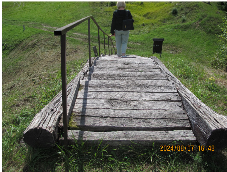
Susidėvėję mediniai laiptai į piliakalnio PV šlaite
