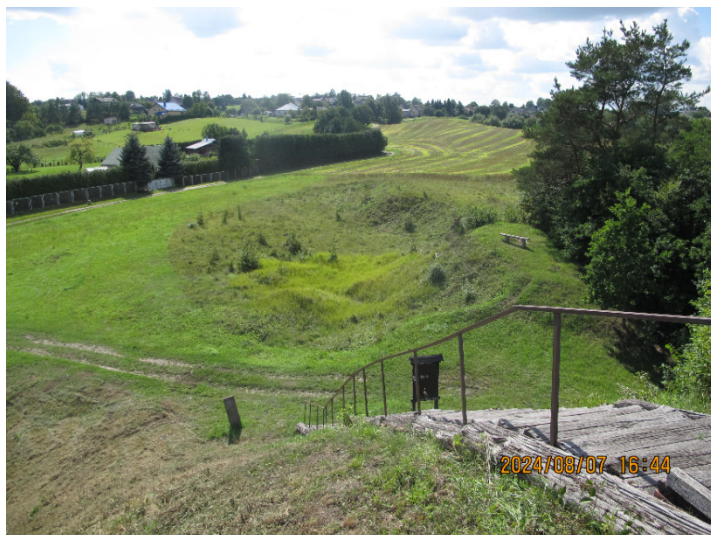
Esami laiptai PV šlaite. Vaizdas nuo piliakalnio link senovės gyvenvietės į V nuo piliakalnio
